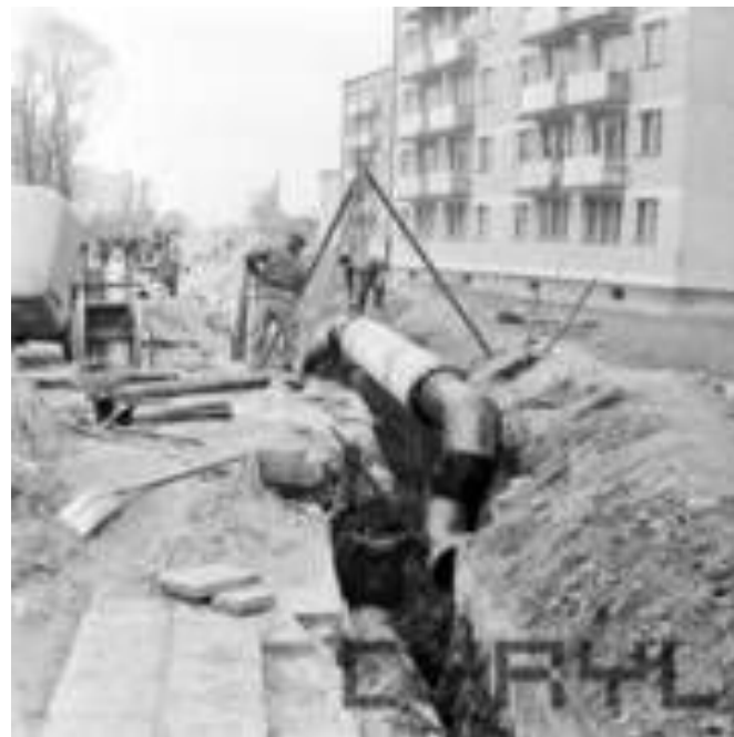
Budowa gazociągu przy Czechosłowackiej, 1973 r.
